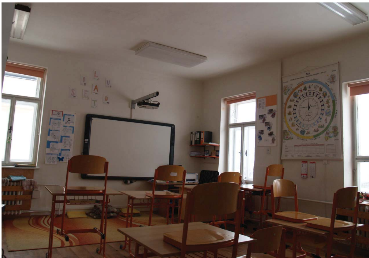
6 - Typická místnost, zářivková svítidla a litinové článkové otopné těleso s termoregulační hlavici a viditelnými rozvody otopné soustavy
