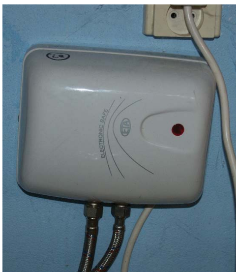
13 - Průtokový elektrický ohřivač ETA 0733
