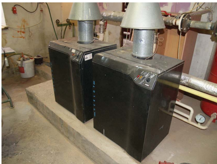
12 - Plynové kotle Destila DPL 50 a
