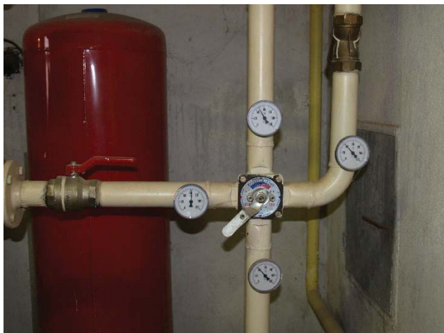
10 – čtyřcestný směšovací ventil
